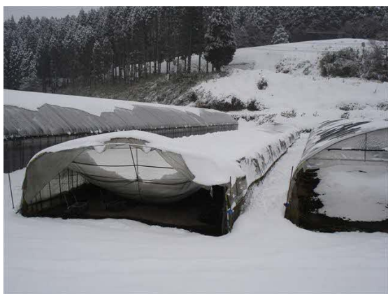
雪下ろしや補強、被覆物の除去などをしないと押しつぶされるようにハウスが倒壊する
