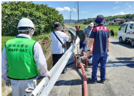
【暫定取水のためのポンプ設置】
