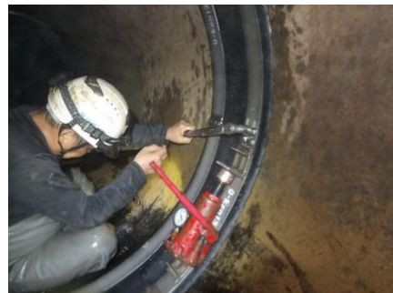
【幹線水路(φ1350 mm)の補修状況】
